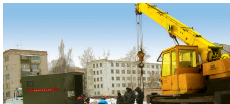
Выезд «аварийщиков» теплосетей напоминает работу «Службы спасения», где одним специалистами без спецтехники поврежденные оперативно устранить невозможно.
